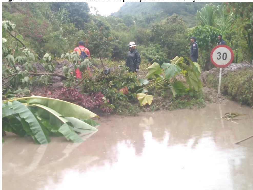
Figura 6. Movimientos en masa en la vía principal-sector Rio Ovejas
