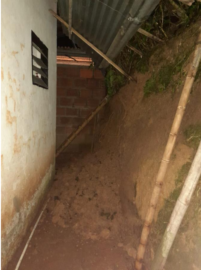
Figura 4. Fotografía Deslizamiento en el Sector de Barrio Bello.
