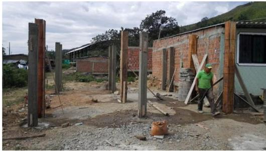
*Ilustración 30.Desenconfrado de columnas 2*
