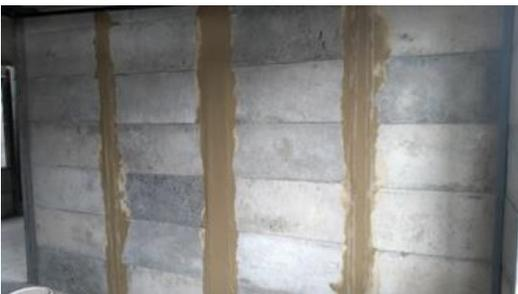
Ilustración 64. Sellado de juntas de unión.
