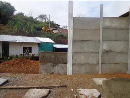
Ilustración 63. Colocación de placas.
