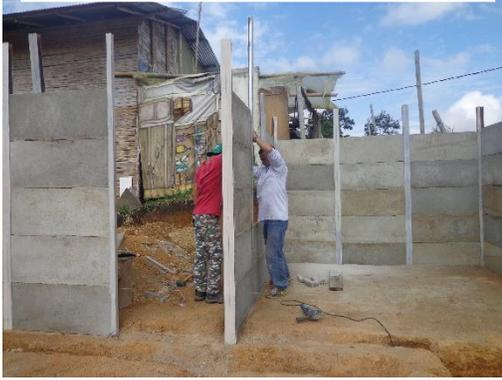
*Ilustración 10. Muros con prefabricados*
