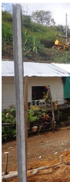
**Nivelación vertical de los perfiles:** Los perfiles deben de estar equilibrados con dados de concreto o un solado de concreto en su defecto para poder sostenerse con antelación la siguiente actividad de fundición.
