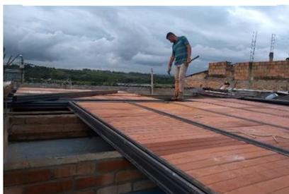
*Ilustración 20. Colocación de placa*
