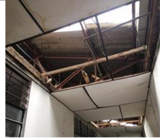
Teja de fibrocemento y estructura en madera
