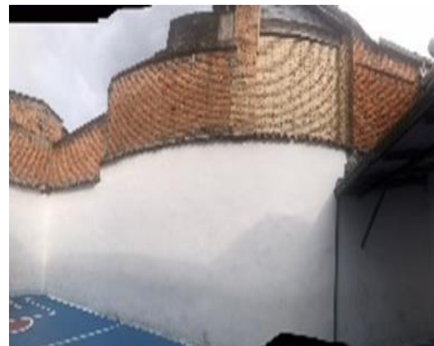
Muros colindantes en condición de deterioro, y la utilización de varios sistemas constructivos
