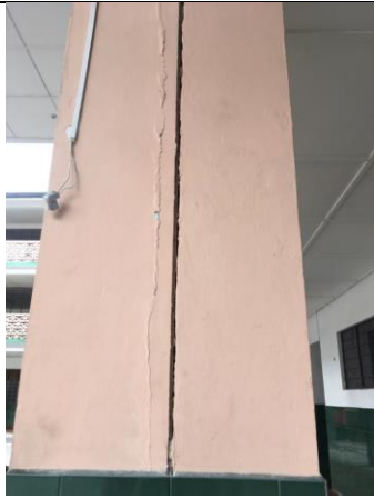
Secciones de columnas dilatadas sin mantenimiento y cables sin proteccion
