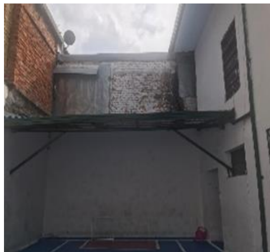
Muros colindantes en condición de deterioro, y la utilización de varios sistemas constructivos
