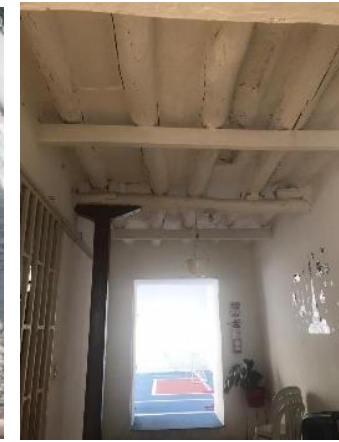
Imagen. Pasillo acceso patio 3
