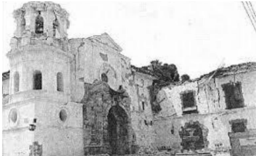
Figura 4. Daños en el Templo y claustro de Santo Domingo por el terremoto del 31 de marzo de 1983. (Alcaldía de Popayán; Universidad del Cauca, 2017)
