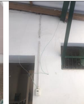
Instalaciones electricas e hidraulicas a la interperie con desgaste de las acometidas.
