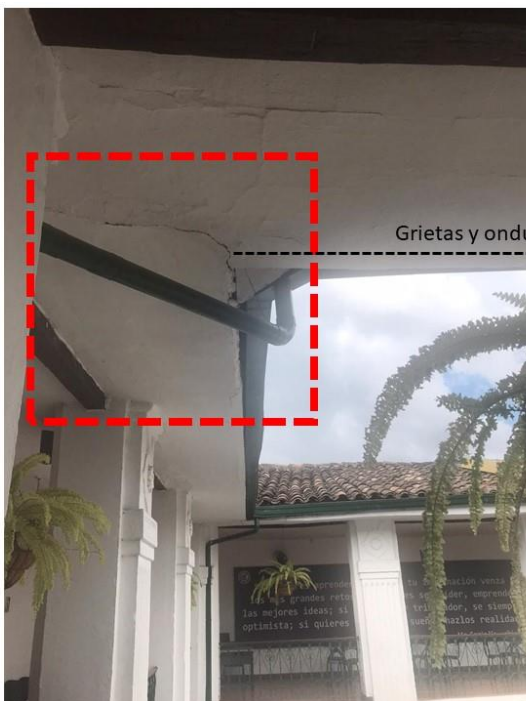
Figura 18. Fallas de los elementos en cubierta y cielos falsos.
