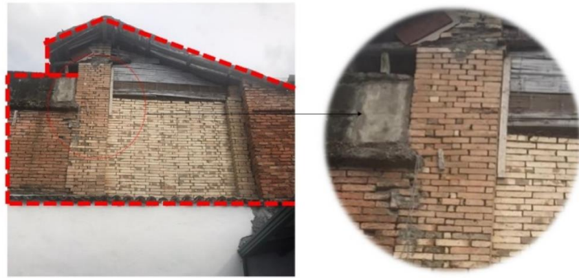
Figura 23. Muro interno, patio 3 Centro Pedagógico Creativo del Cauca.
