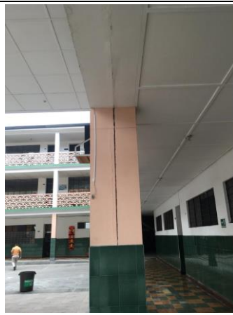
Secciones de columnas dilatadas sin mantenimiento y cables sin proteccion
