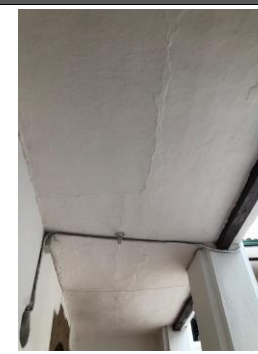
Abultamientos y agrietamiento de el cielo raso correspondientes al tercer patio del edificio.
