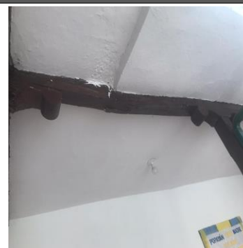
Abultamientos y agrietamiento de el cielo raso correspondientes al tercer patio del edificio.
