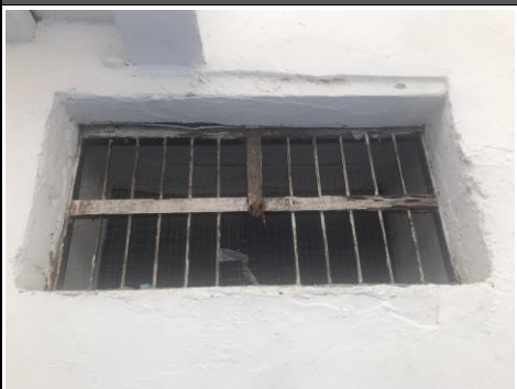
Se evidencia el deterioro en áreas de ventilación pequeñas
