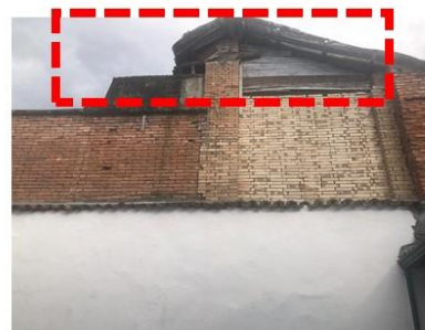
Figura 17. Elementos de adición en Cubierta del Centro Pedagógico Creativo del Cauca.
