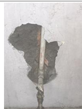
Instalaciones electricas e hidraulicas a la interperie con desgaste de las acometidas.
