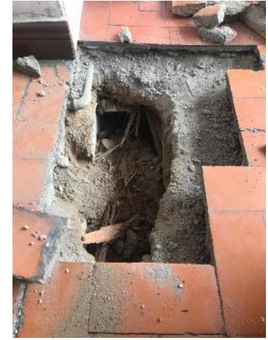
Imagen. Intervención en pisos
