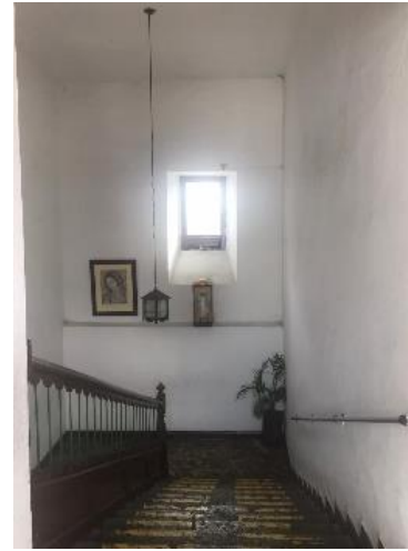
Imagen. Escalinatas acceso segundo nivel
