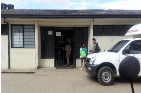
Imagen 50. Acceso Externo Hospital
