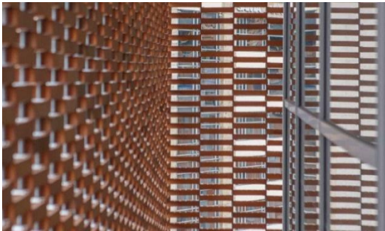
Imagen 21. Elementos arquitectónicos que permiten iluminación y ventilación
