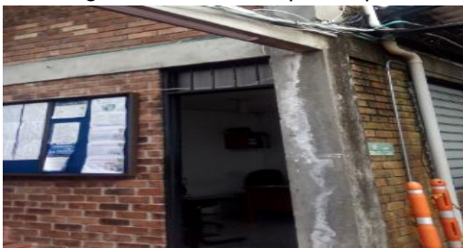
Imagen 71. Oficina de primer piso
