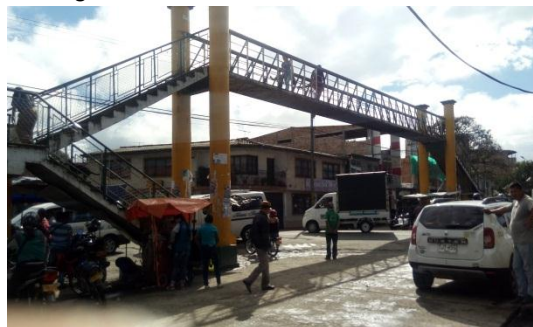
Imagen 41. Puente Peatonal en el sector
