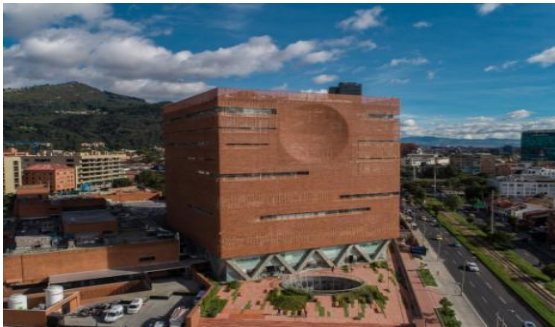
Imagen 17. Fachada de la Fundación
