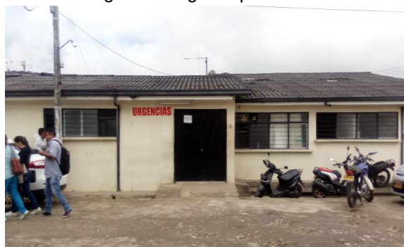
Imagen 78. Ingreso parte externa
